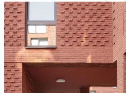
Verbijzondering metselwerk: reliëf
