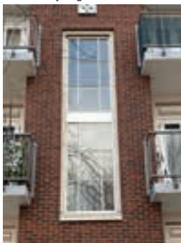
Verticaliteit trappenhuizen met verfijning en ornamenten
