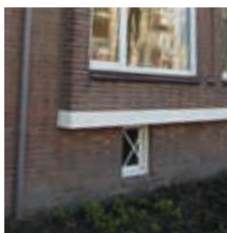
continue betonnen banden geven contrast en relief
